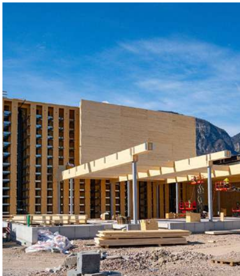
Il primo magazzino automatico autoportante in Italia con struttura in legno. Cortaccia (Bolzano)
