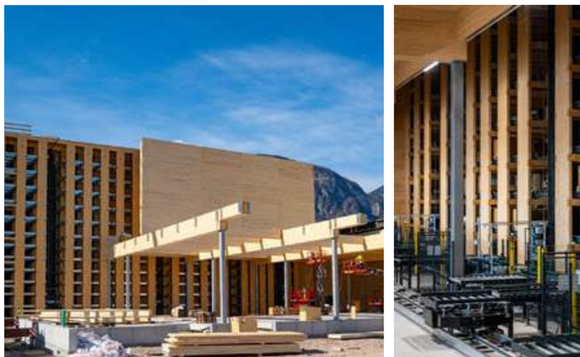
Il primo magazzino automatico autoportante in Italia con struttura in legno. Cortaccia (Bolzano)
