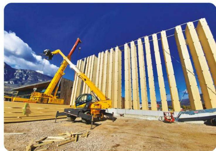
A Cortaccia, in Alto Adige, Automha sta costruendo il primo e unico magazzino automatico con scaffalatura in legno in Italia
